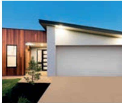
Habitations préfabriquées en béton Fertighäuser aus Beton
